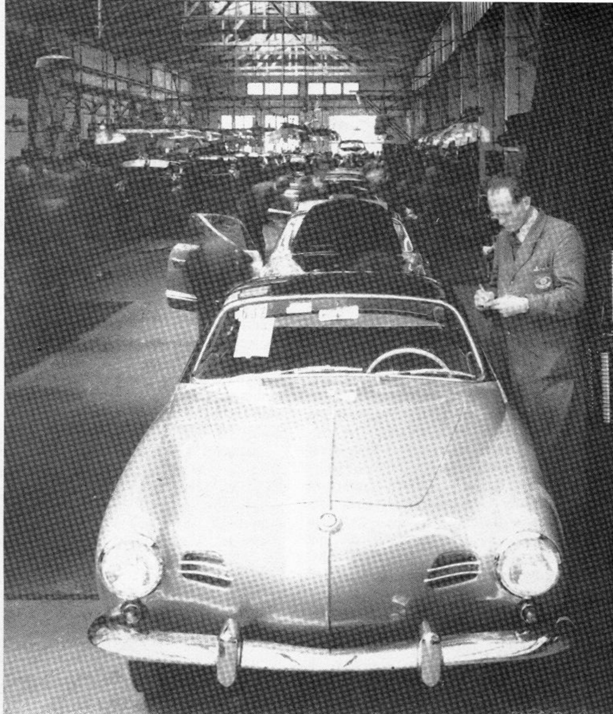
Blick in die Montagehalle bei Karmann in Osnabrück. Das Coupé im Vordergrund wird gerade von einem Ingenieur zur Endkontrolle übernommen.
